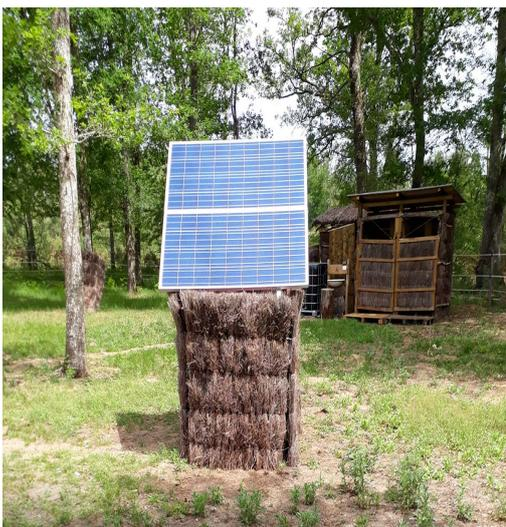
Lors de la mise en œuvre du système, il est apparu que la production électrique du panneau solaire n'était pas optimale : les panneaux étant fixés au sol, ils ne suivent donc pas la course du soleil durant la journée.
